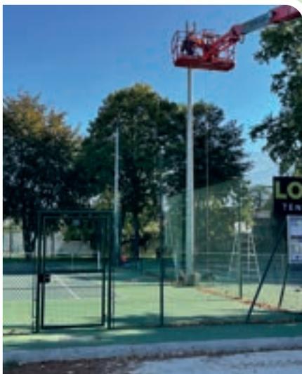
Fin septembre une rénovation complète de l'éclairage du tennis a été réalisée. Ces travaux consistent notamment à mettre en place un dispositif à LEDS .
